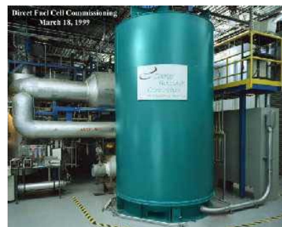
Impianto Direct Fuel Cell da 250 kW
